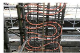
▲壁柱コンクリート内に冷温水配管を敷設
