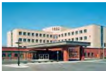
病院(羽幌病院)
