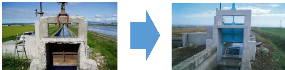
老朽化した用水路の補修状況
