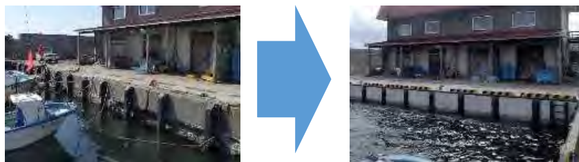
係船岸の施設の修繕状況
