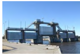
水門 琵琶瀬漁港海岸（浜中町）
