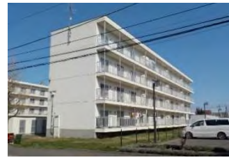
職員住宅(札幌市)
