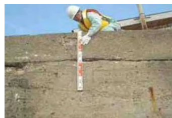
護岸の点検状況
