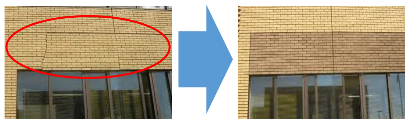
外壁タイルの浮き・ひび割れの補修
