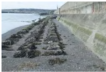
護岸 厚岸漁港海岸（厚岸町）
