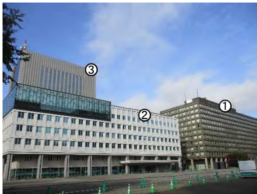
① 庁舎等 (北海道庁本庁舎) ② 庁舎等 (北海道議会庁舎)
