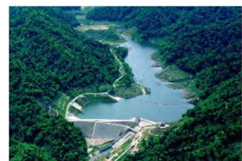
防災ダム 上小川地区(苫前町)
