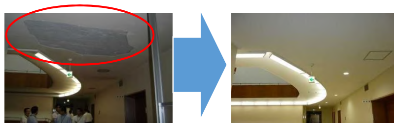
天井(しっくい)剥落の補修
