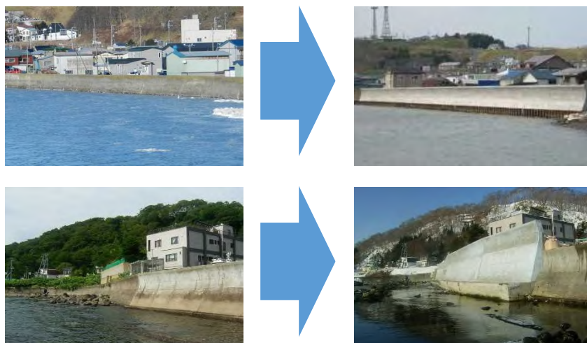
護岸の修繕状況
