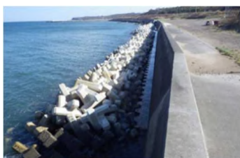
海岸保全施設 砂原地区(森町)
