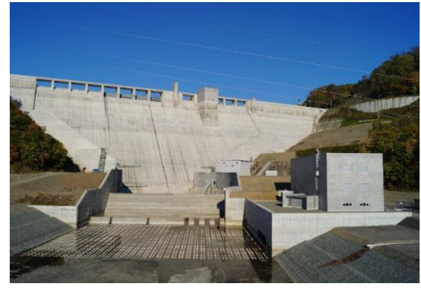
シューパロ発電所と夕張シューパロダム
