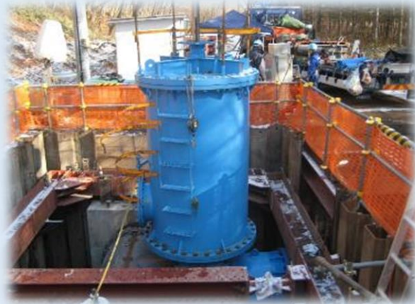
工業用水道管布設工事 (不断水挿入弁工施工状況)
