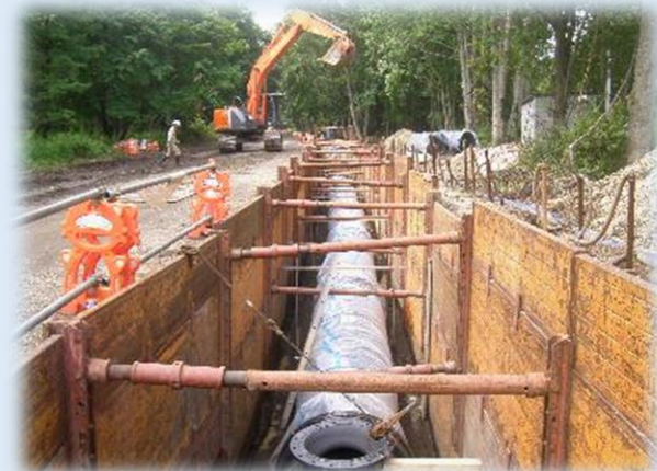
工業用水道管布設工事 (管設置状況)
