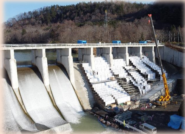
清水沢発電所改修工事（ダム改修状況）
