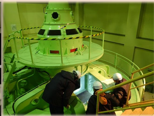
鷹泊発電所 (巡視点検状況)
