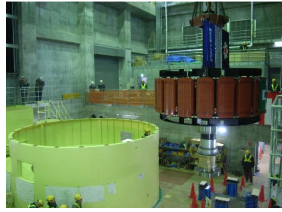
シューパロ発電所（1号発電機の回転子吊込）
