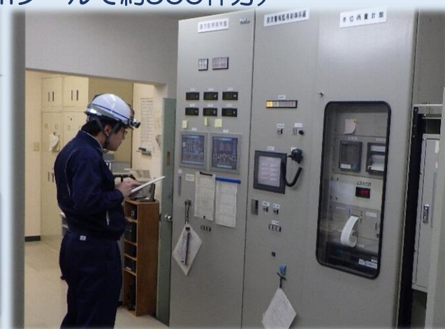
室蘭地区工業用水道幌別ダム (巡視点検状況)
