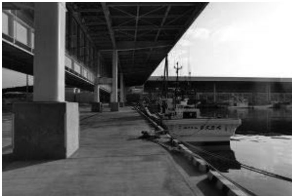
衛生管理強化のため屋根付岸壁を整備した漁港 常呂漁港（北見市）
