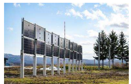
垂直型両面太陽光パネル UNIVA JAPAN HPより
