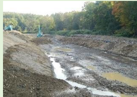
河道掘削状況
