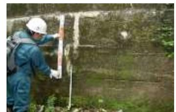
砂防堰堤のクラック点検状況
