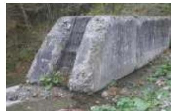
砂防堰堤の老朽化状況
