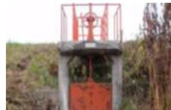
樋門の老朽化状況 (扉体の塗装劣化)
