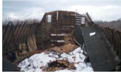
大雪により倒壊した施設
