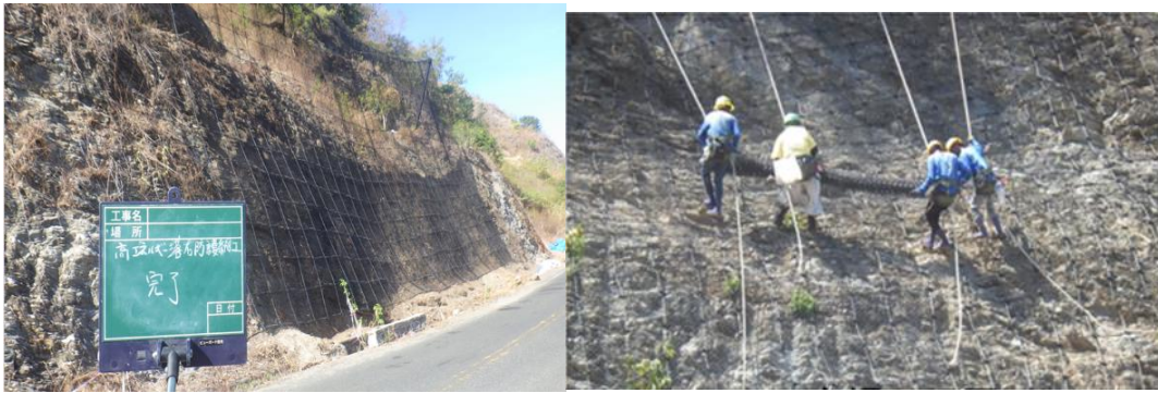
(写真：(左)東ティモールでの落石防護金網設置現場、(右)設置作業 提供/(株)ヤマコウ工業)
