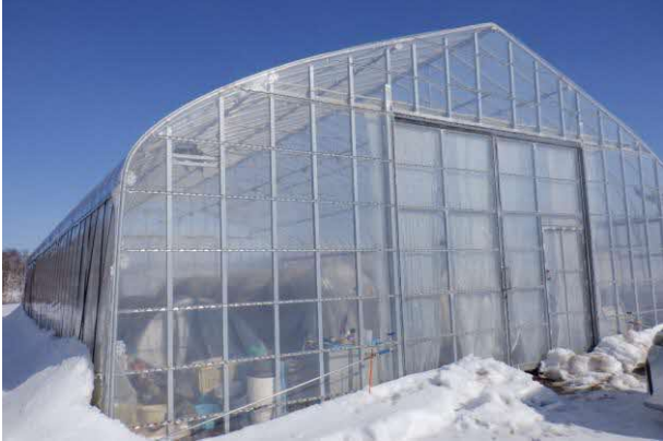
実証実験ハウス (現在は未使用)
