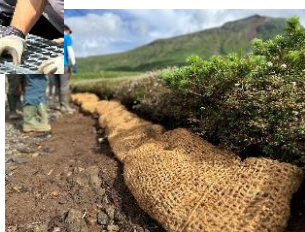
ヤシ繊維マットによる施工
