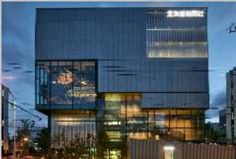
道新ビル正面外観
