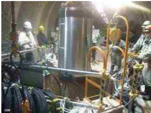
人工バリア性能確認試験（オーバーバックの設置）
