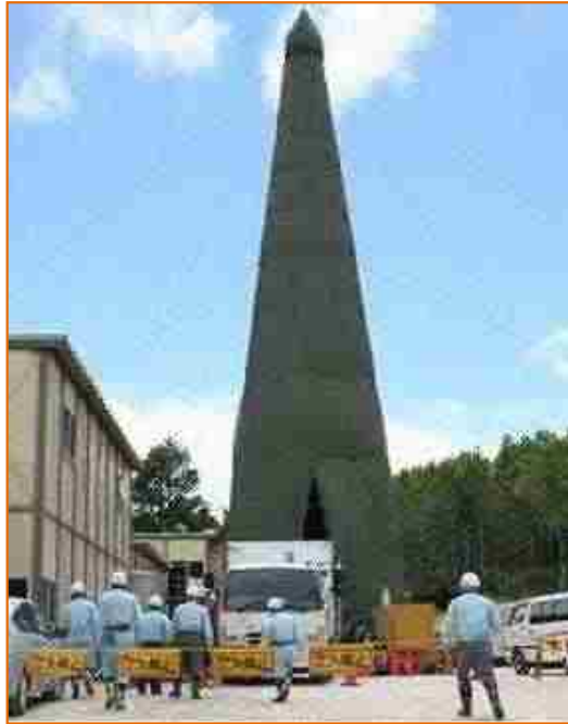
ボーリング調査 (HDB-11孔)
