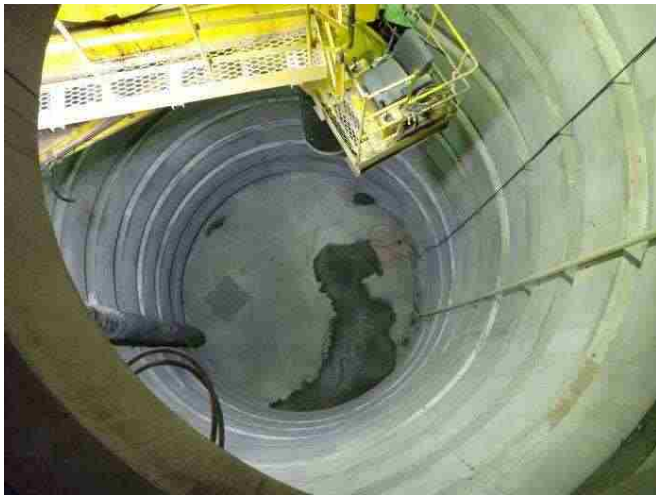
西立坑 (平成26年3月26日撮影)
