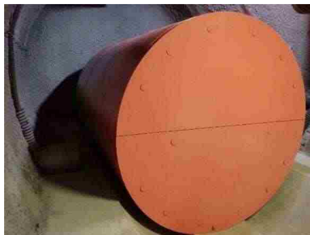
模擬PEMの設置状況
