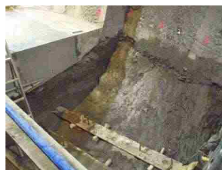
切り欠きの掘削とプラグの施工例
