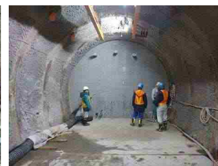
切り欠きの掘削とプラグの施工例
