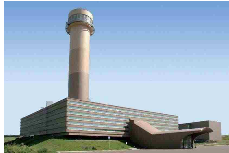
「ゆめ地創館」(平成19年6月30日開館) 地下深部での研究内容を紹介 * 地下施設の工事状況等をリアルタイムでご覧いただけます。
