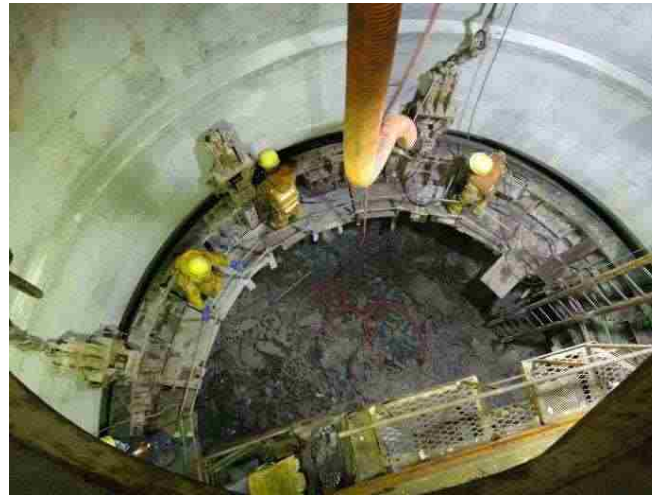
東立坑 (平成26年3月26日撮影)
