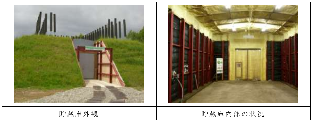
写真 3-2-3 八千代ヒートパイプ型凍土低温貯蔵庫
