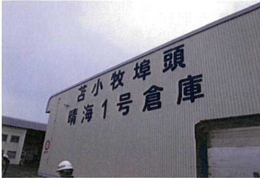
支援物資一次集積拠点の外部(9/7)
