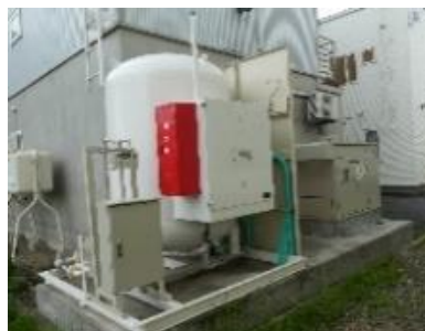
災害用 L P ガスバルク貯槽と非常用 L P ガス発電機
