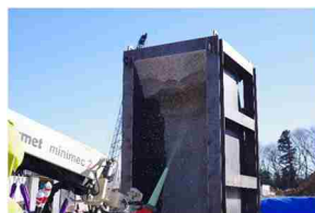
(a) 斜め上方への吹付け
