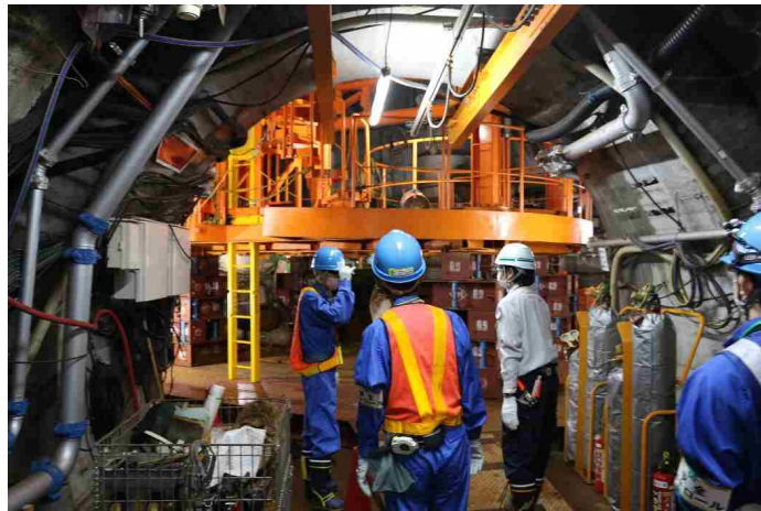
図 116 安全パトロールの状況
