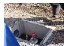
集中管理孔を併設した暗渠排水
