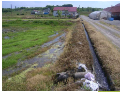
用水路からの漏水状況
