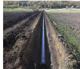
パイプライン化後の用水路
