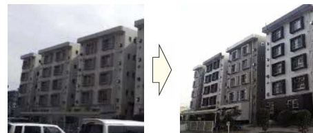
既存の団地改修のうち、断熱性能の向上のための窓枠改修工事
