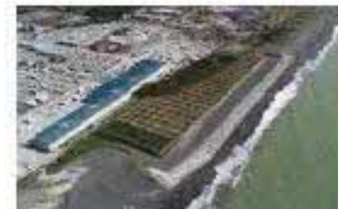
海岸防災林造成（むかわ町）
