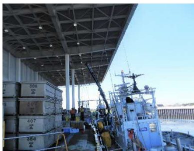
[屋根付き岸壁等の整備]
