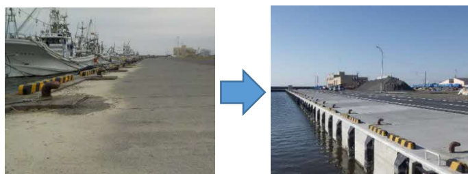
[北海道胆振東部地震で被災した岸壁を復旧]
