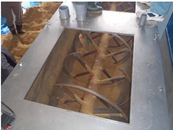
減量化槽内（内容物取り出し後）
