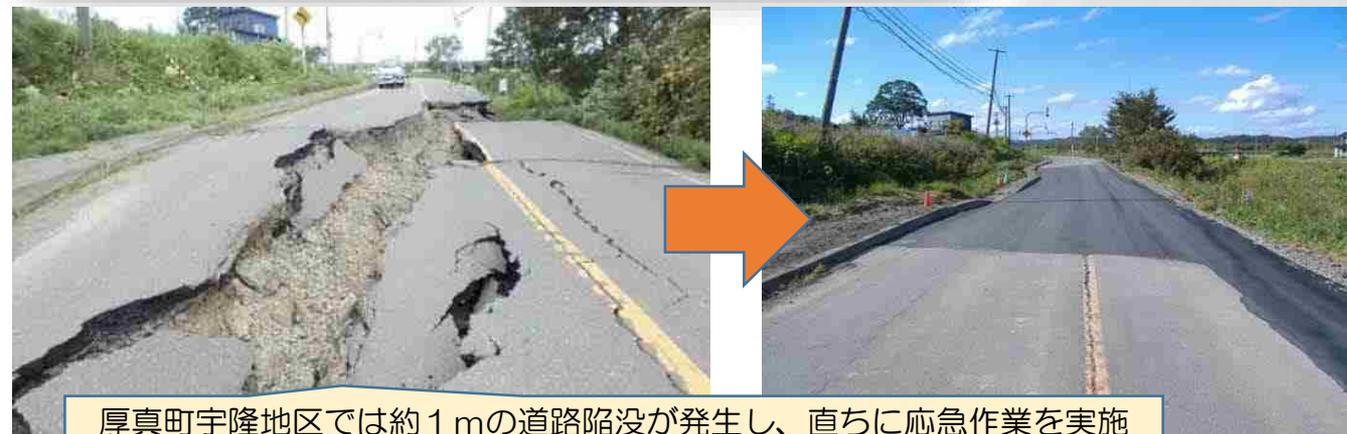
厚真町宇隆地区では約1mの道路陥没が発生し、直ちに応急作業を実施
