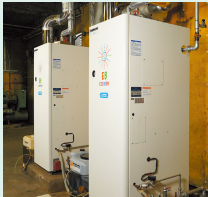
ボイラ容量を400kg/hから250kg/hに変更、A重油からLPGに燃料転換
