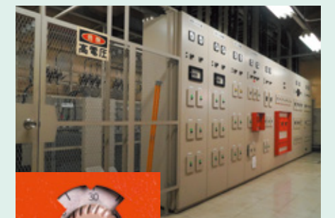
電気室換気ファンの設定温度を25℃から30℃に変更
