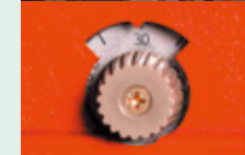
電気室換気ファンの設定温度を25℃から30℃に変更
