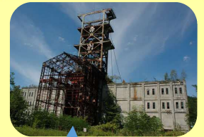
奔別炭鉱立坑槽
