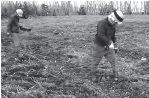
写真7 充電ドリルを用いたオーガの例
