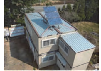
現場事務所への ソーラーパネルの設置
