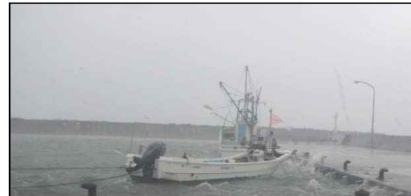
○港内の静穏状況 荒天時の港内静穏が悪く、漁船の係留に支障がある。
