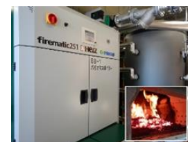
木質バイオマスボイラー
