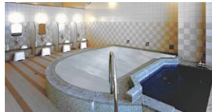
浴槽水面の保温シート敷設
