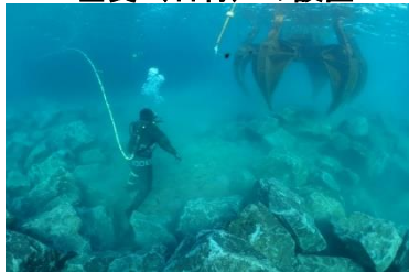
基質（石材）の設置
