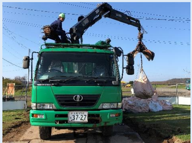
安平町 仮置き場 積卸風景
